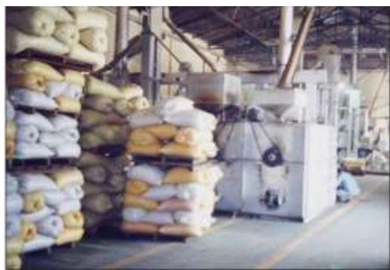
• 가공기계의 3단계 설치 완료 (들것 약 400톤 생산가능)
